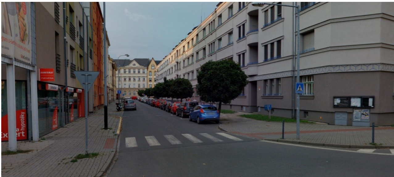
Obrázek 9.4: Rekonstrukce místa pro přecházení Sokolská, snížená obruba, doplněné signální i varovné pásy
