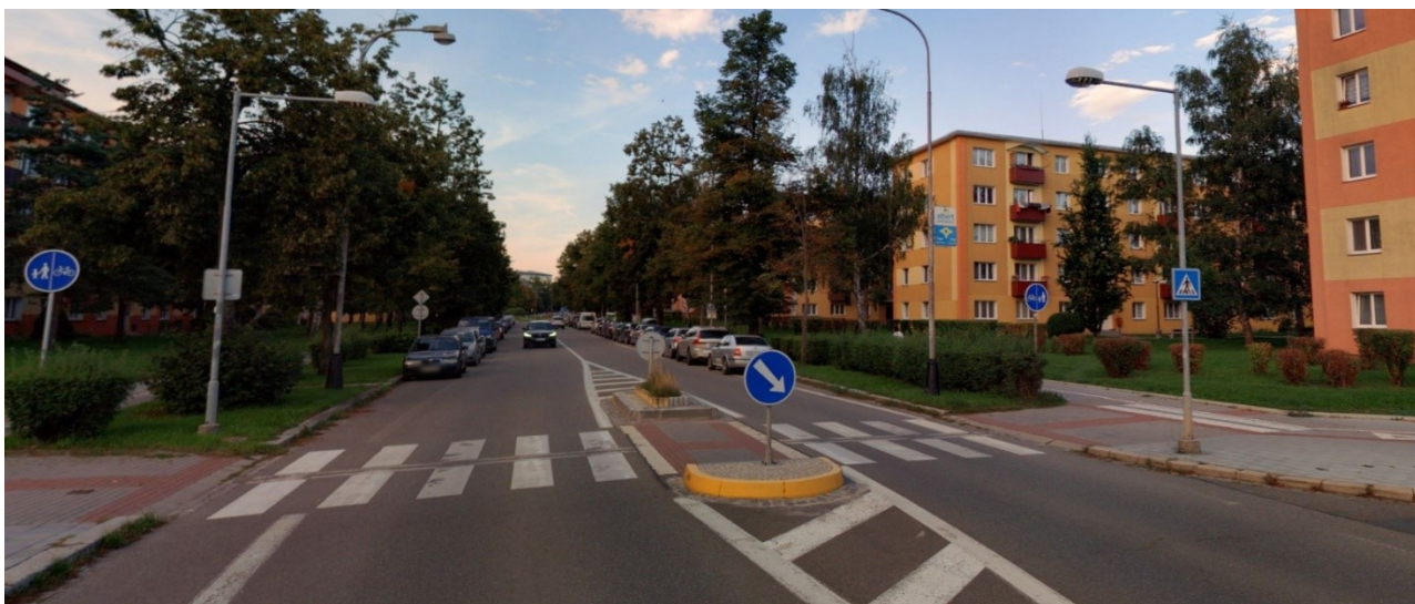
Obrázek 9.14: Provedení přechodu bří Hovůrkových x Kouřilkova, přechod se středním dělením se speciálním nasvětlením
