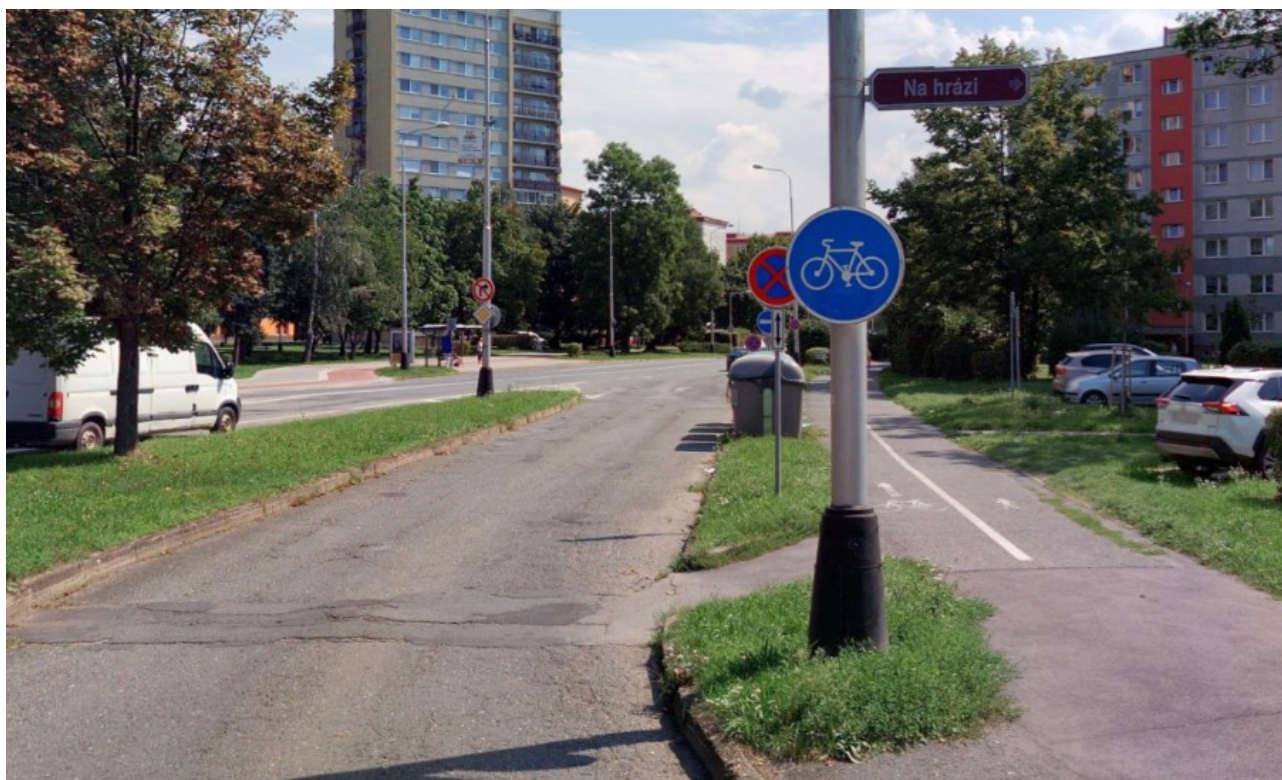
Obrázek 8.4: Příklad chybného svislého dopravního značení a nedostatečné oddělení pěší a cyklistické části stezky – Velká Dílážka, 2024
