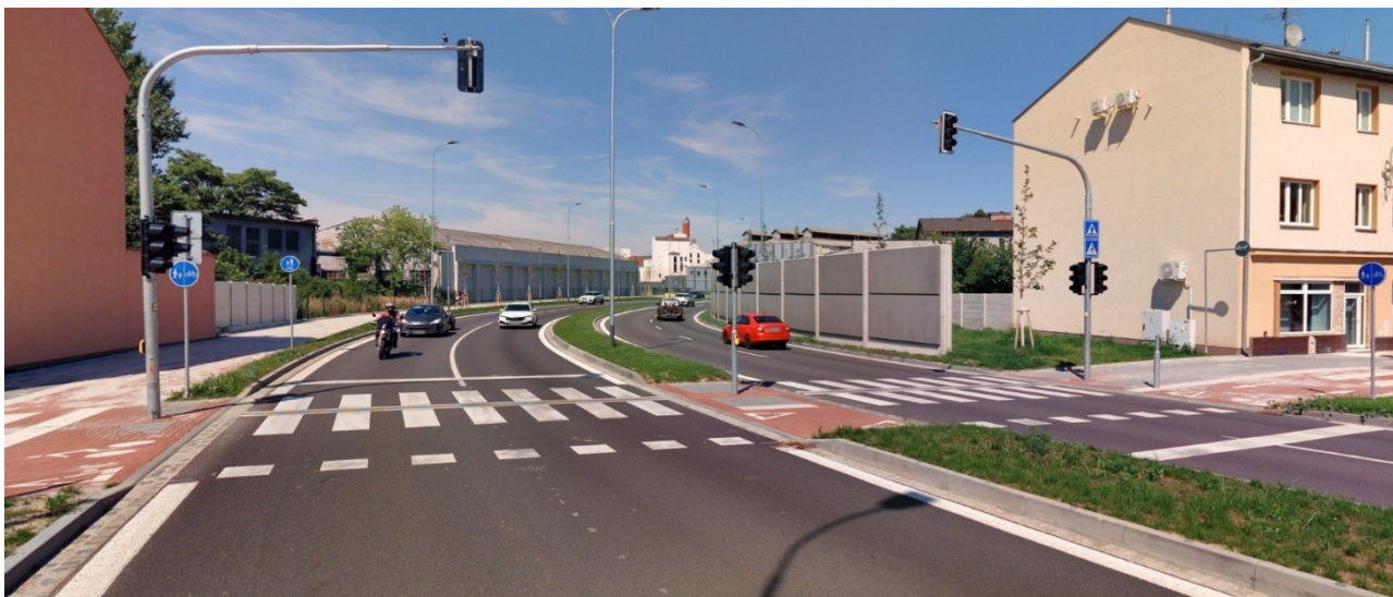
Obrázek 9.2: Realizace nového přechodu pro chodce na průtahu městem
