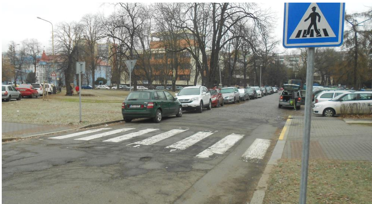
Obrázek 9.4: Nedostatečné rozhledy z přechodu před ZŠ Svisle; přechod vhodné zkrátit a chránit vysazenou plochou, která zamezí parkování min. 5 m před přechodem dle zákona; chybně proveden varovný pás, chybí signální pás
