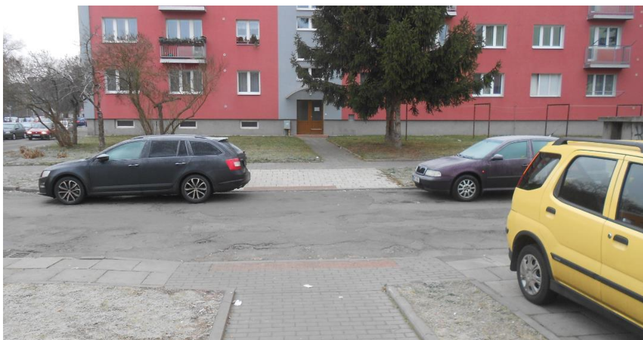
Obrázek 9.2: Částečně vyhovující místo pro přecházení, chybí signální pásy; nevyhovující z hlediska rozhledu vlivem parkujících vozidel; Svisle
