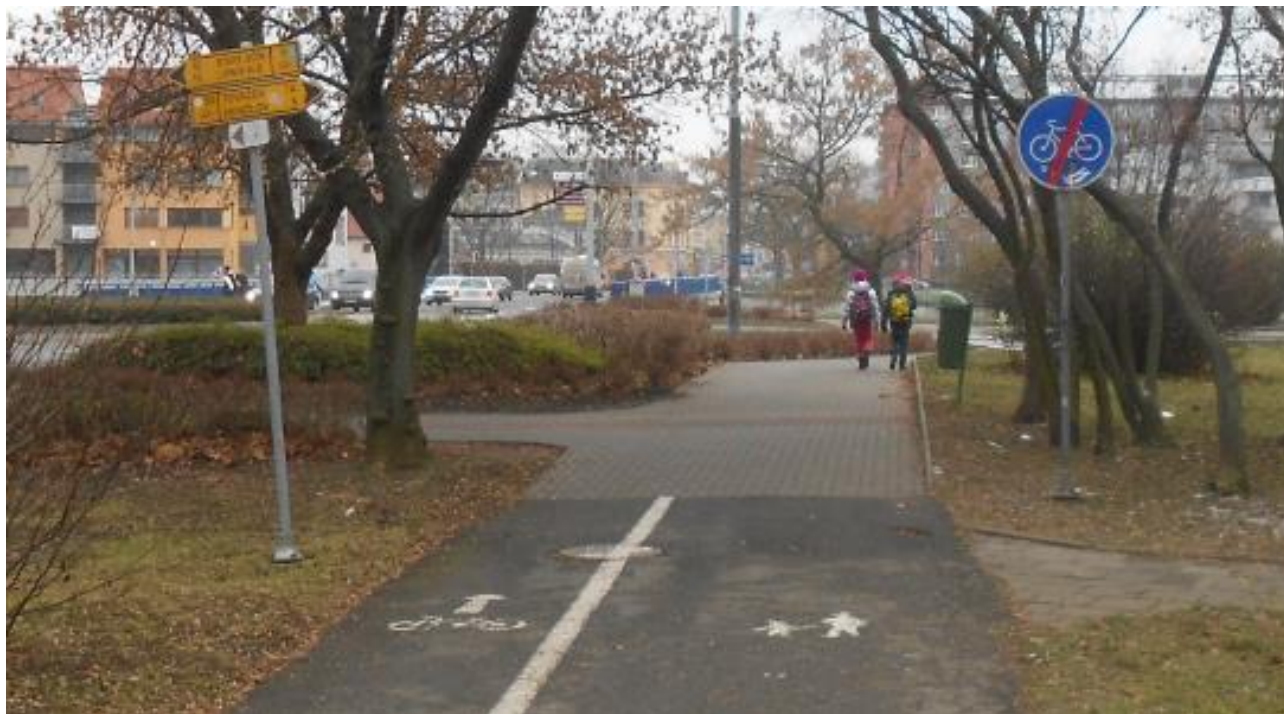
Obrázek 8.3: Příklad chybného svislého dopravního značení a nedostatečné oddělení pěší a cyklistické části stezky – Velká Dílžka
