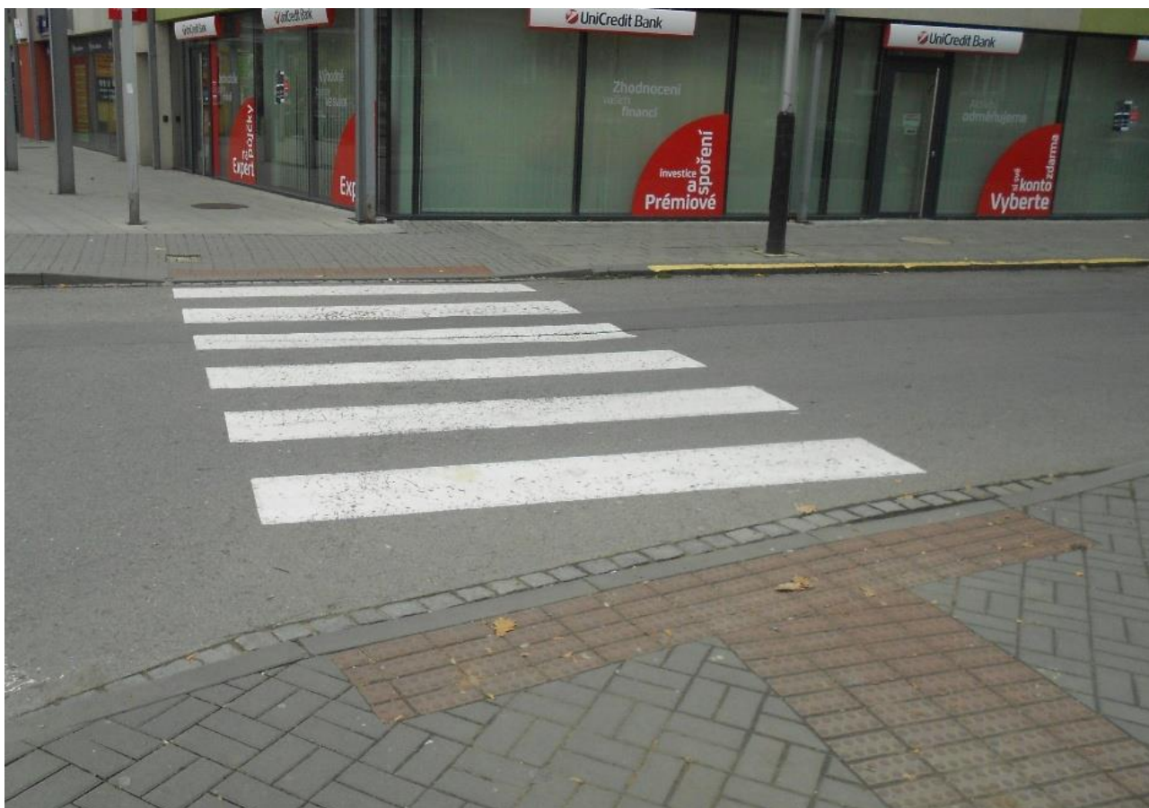
Obrázek 9.6: Částečně vyhovující řešení přechodu pro chodce, chybějící signální pás na protější straně; Čechova x Jaselská
