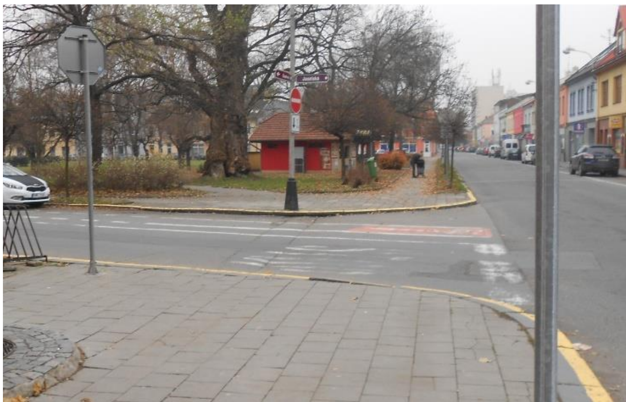
Obrázek 9.4: Nedostatečné rozhledy z přechodu před ZŠ Svisle; přechod vhodné zkrátit a chránit vysazenou plochou, která zamezí parkování min. 5 m před přechodem dle zákona; chybně proveden varovný pás, chybí signální pás
