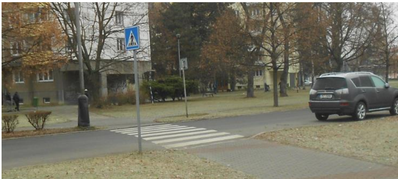
Obrázek 9.6: Částečně vyhovující řešení přechodu pro chodce, chybějící signální pás na protější straně; Čechova x Jaselská
