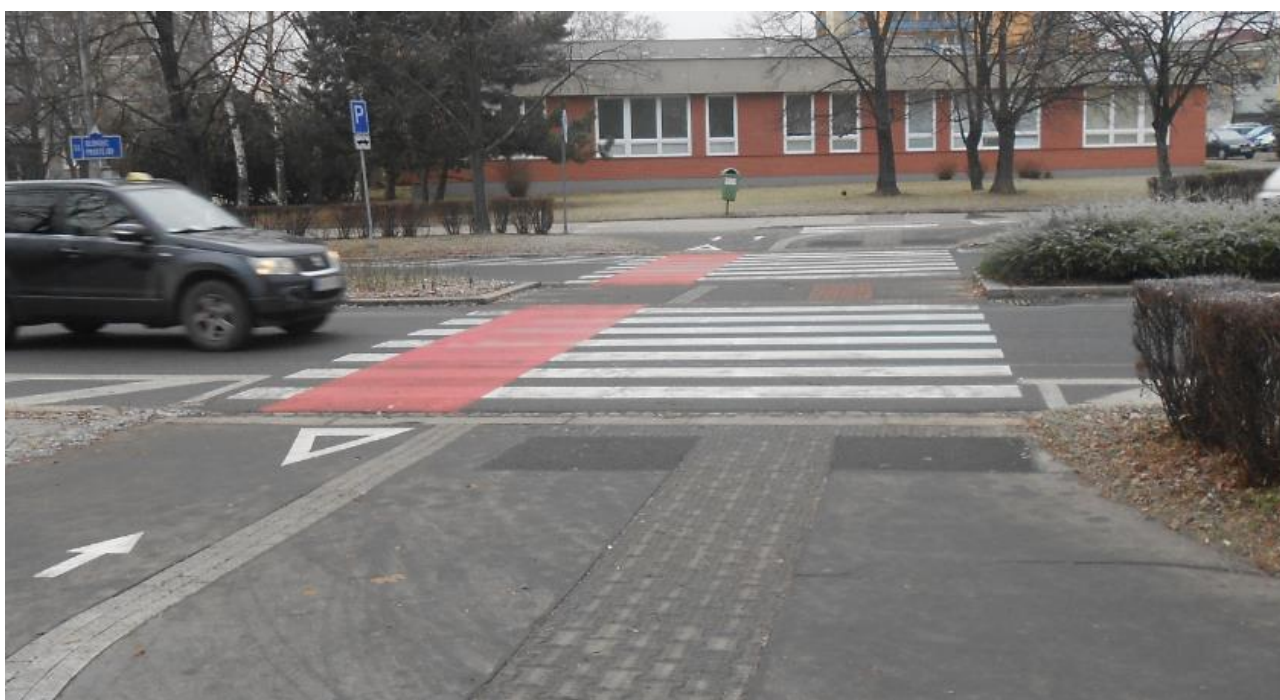
Obrázek 9.8: Částečně vyhovující přechod, reliéfní dlažba není provedena v kontrastní barvě; Želatovská x Dvořákova
