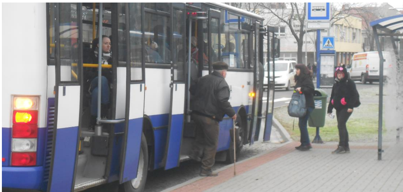
Obrázek 7.4: Příklad nedostatečně rekonstruované zastávky Přerov Prior – chybí nájezdová obruba, nástupiště je nízké
