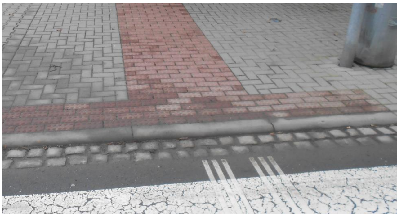
Obrázek 9.8: Částečně vyhovující přechod, reliéfní dlažba není provedena v kontrastní barvě; Želatovská x Dvořákova
