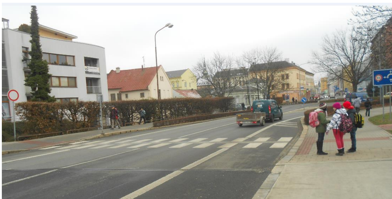
Obrázek 9.2: Částečně vyhovující místo pro přecházení, chybí signální pásy; nevyhovující z hlediska rozhledu vlivem parkujících vozidel; Svisle
